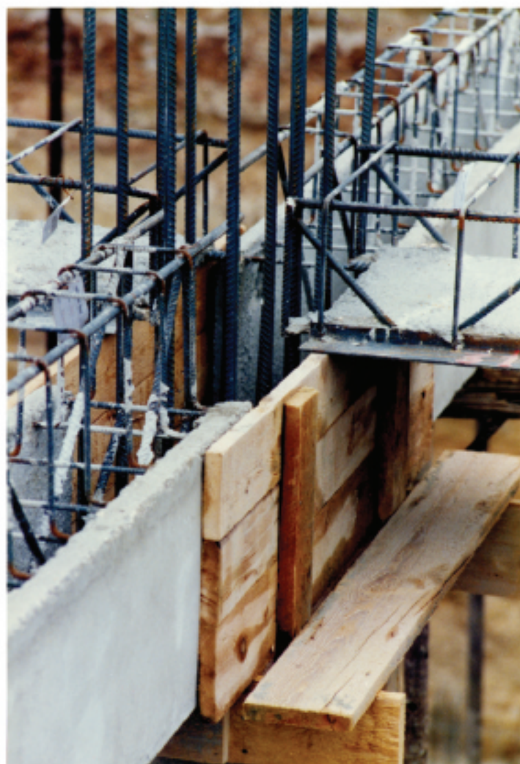
NODO TRAVI - PILASTRO
