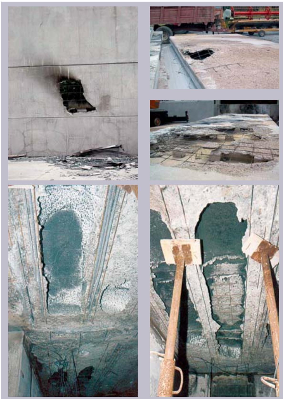
Fig. 3 - Foto di pannelli e solai prefabbricati in c.a. alleggeriti con blocchi in polistirene (PSE) privi di sfoghi: risultato delle esplosioni causate da incendi reali.
